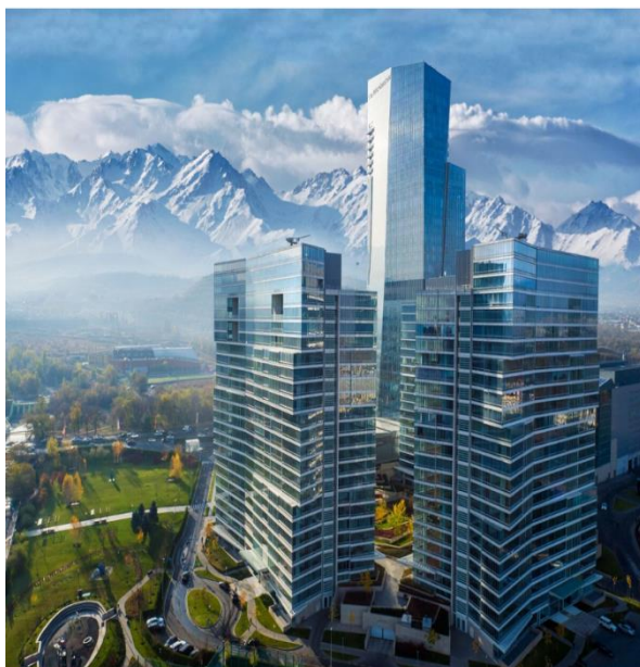
Рисунок 1.1 «Esentai Tower» (г.Алматы, 2008г. высота 168 м., 38 этажей)
