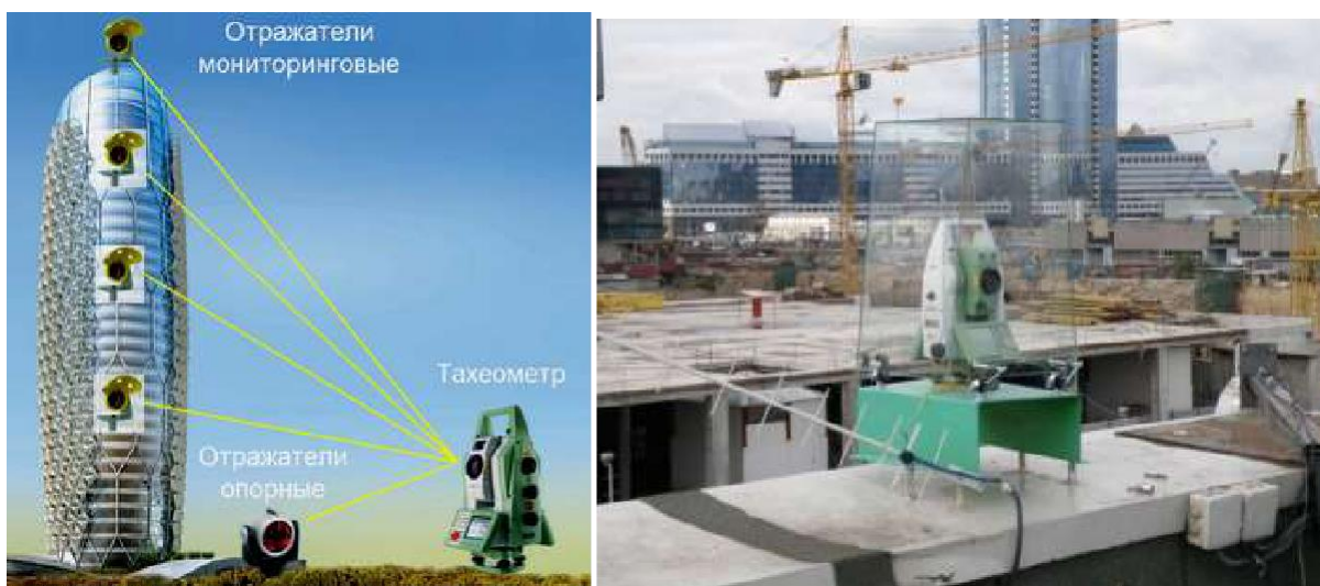
Рисунок 2.1 - Мониторинг здания с применением роботизированного тахеометра
